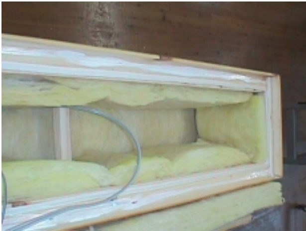
Kuva kaiuttimen villoituksen sijoittamisesta
