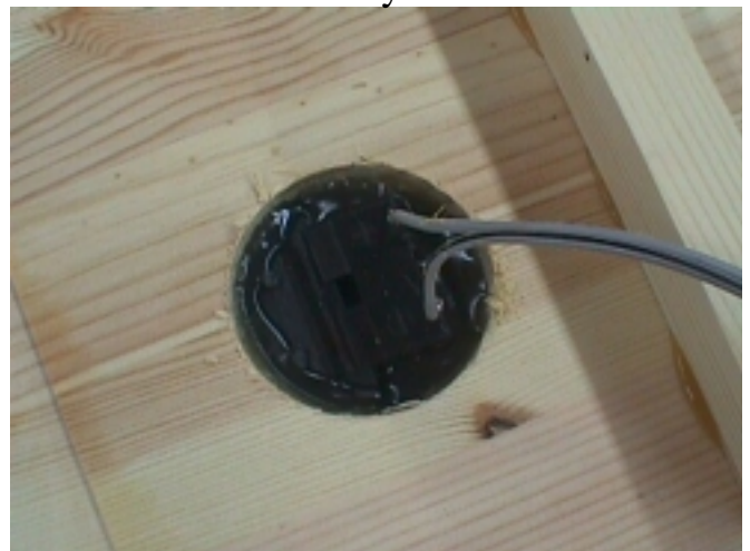
Kaiutinliittimen tiivistys kuumaliimalla
